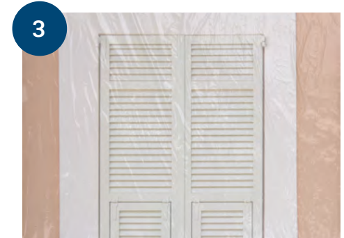
3 Démarrage de l'opération et protection des lieux d'intervention.
