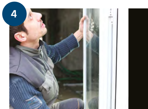
4 Dépose des anciennes menuiseries.
