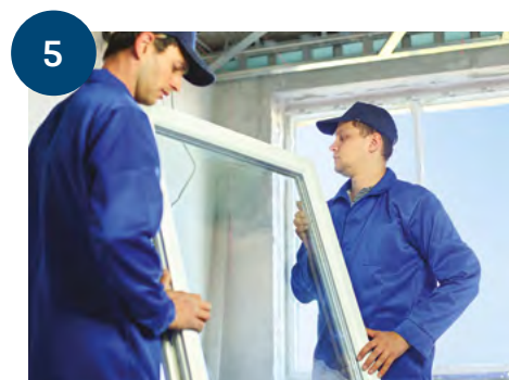
5 Pose des menuiseries neuves FIGUIERE MENUISERIE.
